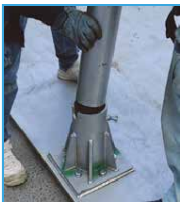
サヤ管に差し込むだけ
